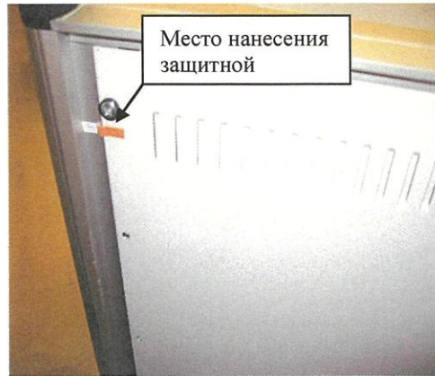
Рисунок 2 - Схема пломбирования корпуса генератора от несанкционированного доступа
